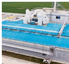
蘇州二葉污水站
