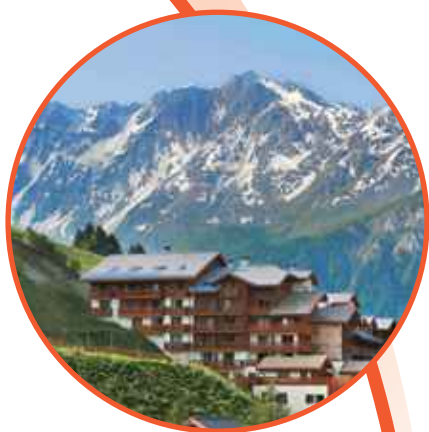
● Club Med Peisey-Vallandry, France
